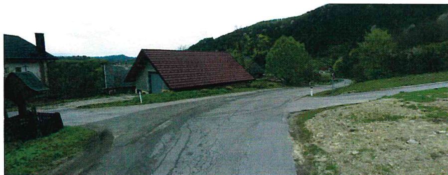
Slika 2: Priključek javnih poti JP 528562 in JP 52563. vozišče razpokano.
